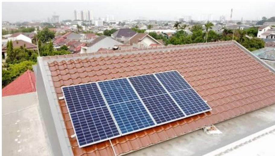
Gambar 6. Rumah dilengkapi dengan Solar cell
